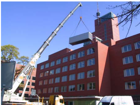
Bild 1: Transport des Containers auf das Dach des RZ Theaterstrasse.
