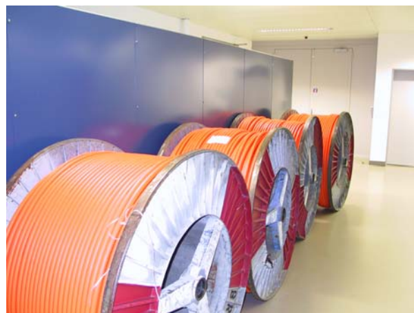
Bild 6.2: Hauptkabel angeliefert und bereit für die Verlegung
