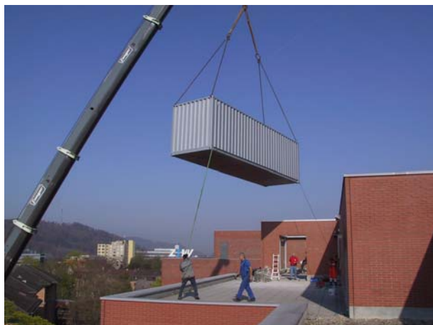
Bild 6.1: Absetzen des Containers am vorgesehenen Montageort auf dem Dach
