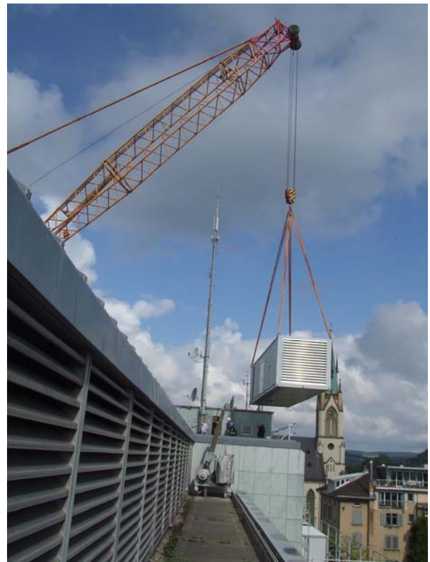
Bild 4.2-2: Transport eines Containers 1800 kVA mittels Pneu- kran auf das Dach
