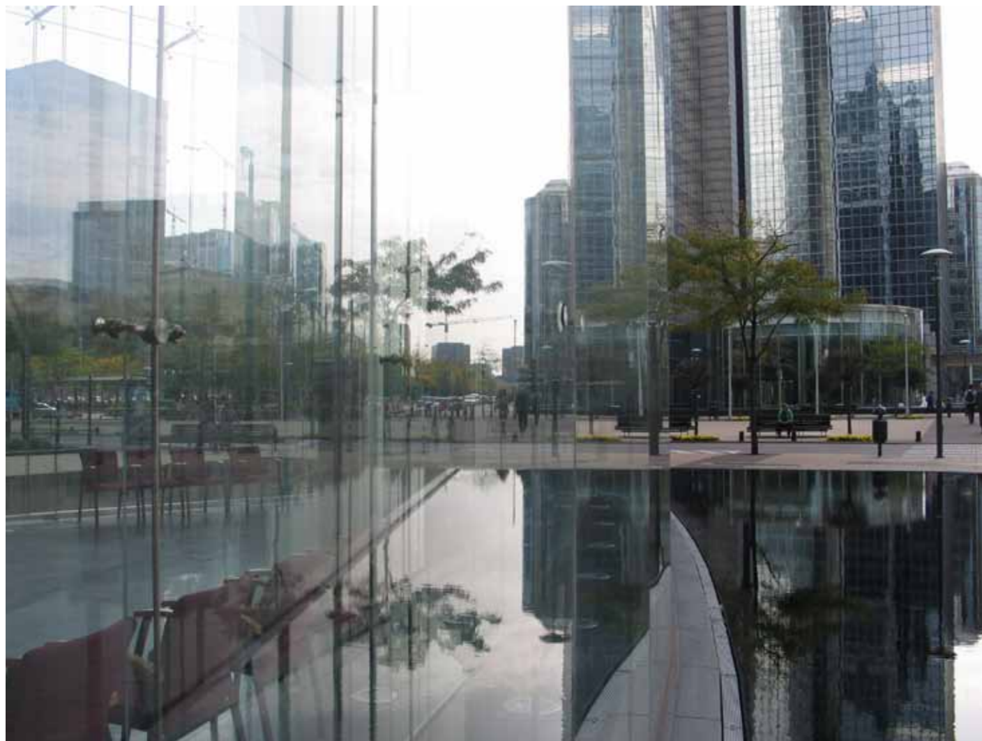
Verdichtetes Bauen stellt hohe Anforderungen an die technische Gebäudeausrüstung
